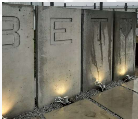
Rys. 1. Po lewej mury zaimpregnowane impregnatem LOVBET, po prawej bez impregnacji.
