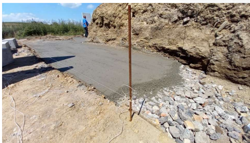
Rys. 3b. Warstwa betonu C12/15
