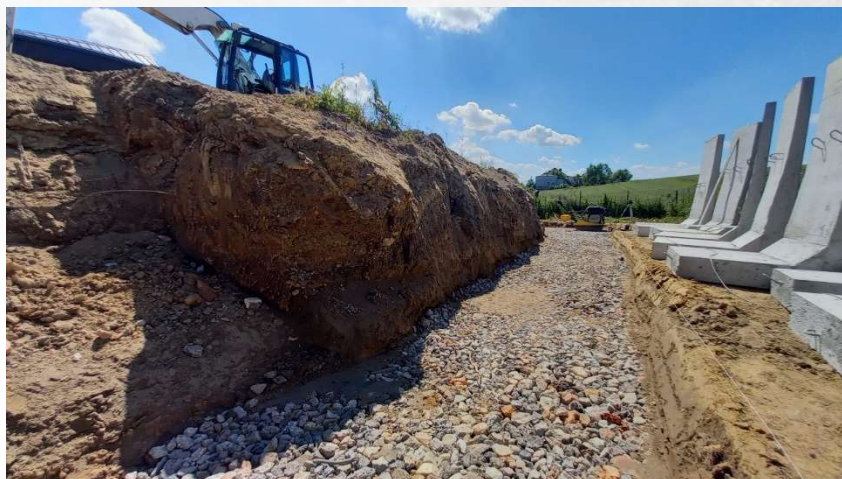
Rys. 3a. Warstwa podbudowy z kruszywa
