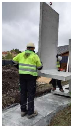
Rys. 1. Początek układania murów ogrodzeniowych na przygotowanym podłożu.
