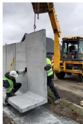
Rys. 1. Początek układania murów ogrodzeniowych na przygotowanym podłożu.
