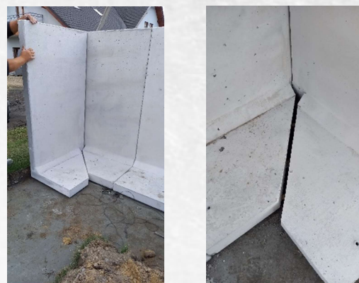
Rys. 5b. Narożniki murów ogrodzeniowych
