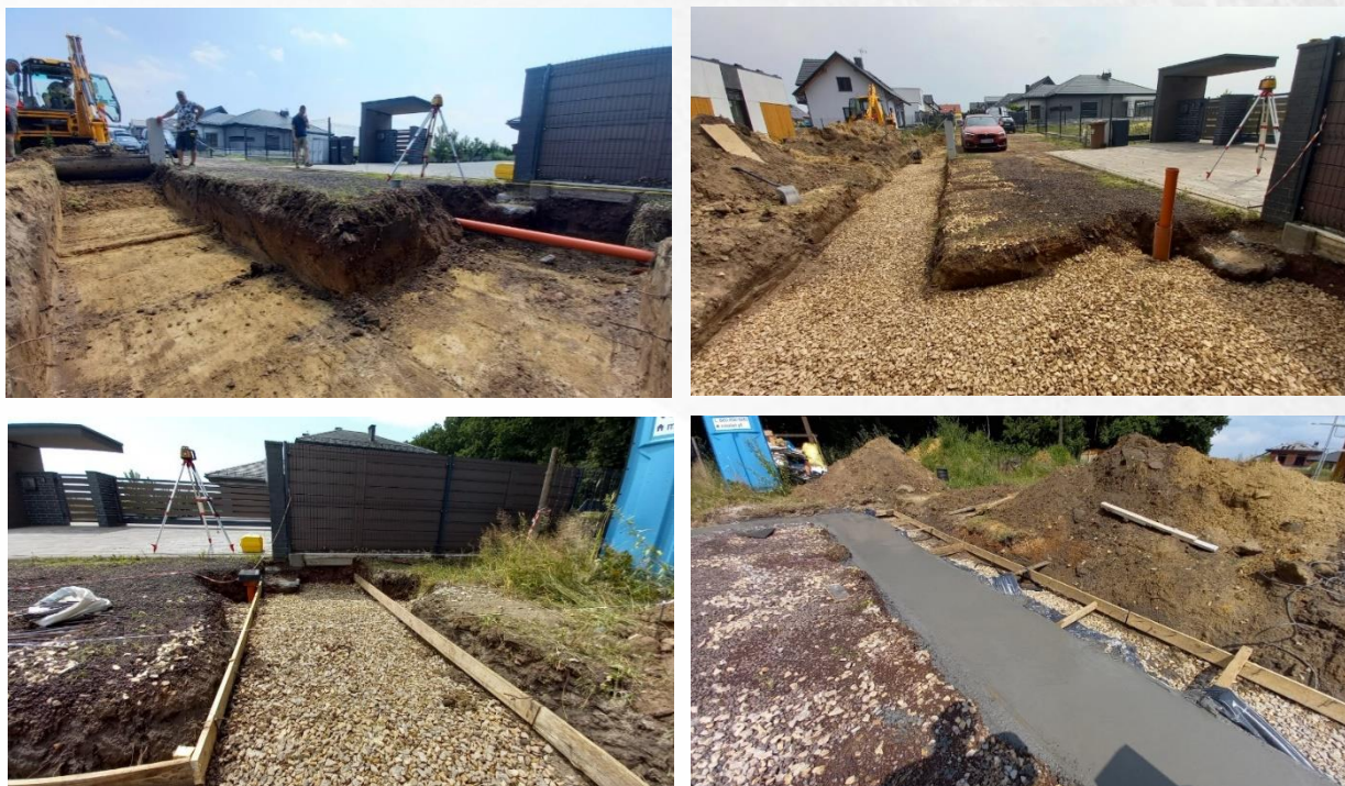
Rys. 2. Kolejne etapy wykonania podbudowy muru ogrodzeniowego (korytowanie, zasypanie kruszywem, przygotowanie szalunku, zalanie betonem).
