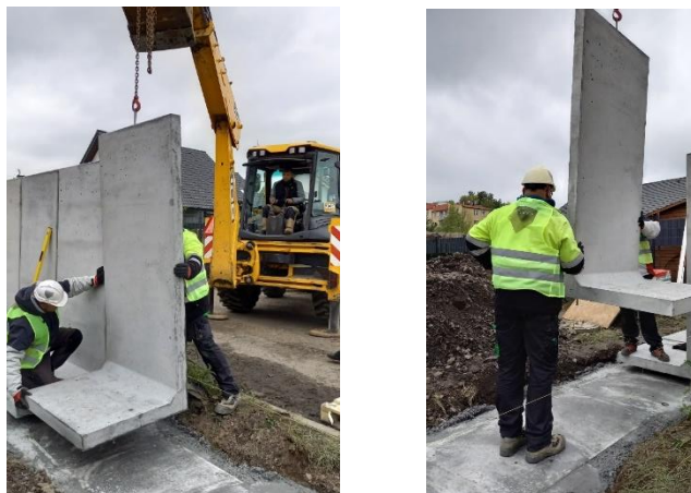
Rys. 1. Początek układania murów ogrodzeniowych na przygotowanym podłożu.
