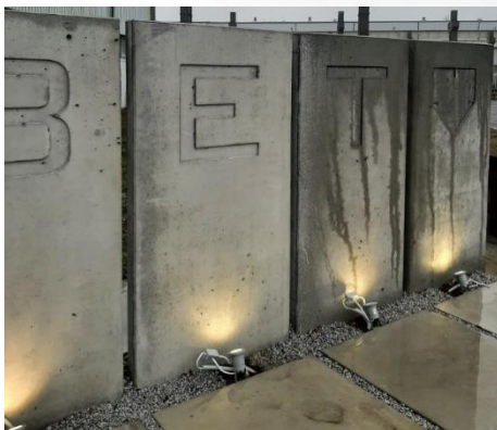
Rys. 6. Po lewej mury zaimpregnowane impregnatem LOVBET, po prawej bez impregnacji
